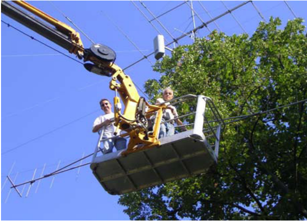
foto by IK4AUY – 2005: Anton IK4UPU e Romano I4FAF nel cestello con la 2m Tonna rimossa dalla sommità del palo.
